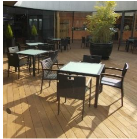
▲含浸材ウッドデッキ
