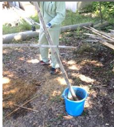
泥塗布 時間経過と共に砂利類 がバケツ下部に沈み込
