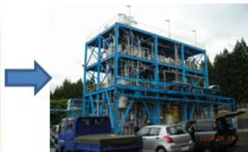
製造プラントを建設
