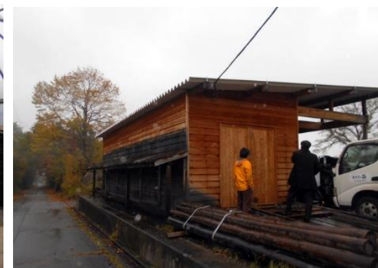
群馬県F社 ボイラー+乾燥小屋
