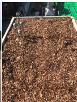
センサー類 取付け
