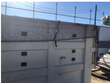
ネットをコンテナに設置
