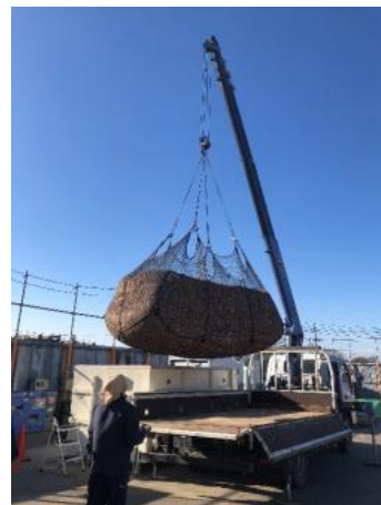
ユニックによる吊上げ
