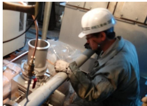
バグフィルタ(左)とプレコート用粉体定量供給機(右)
