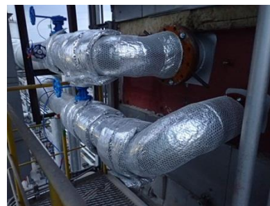
ガスの引き抜き
