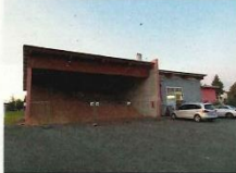
木質チップボイラー
