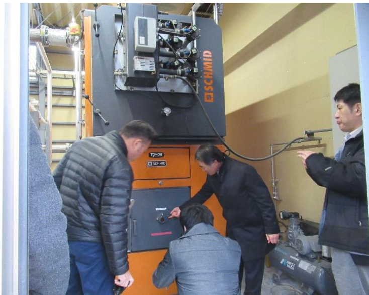
写真-8 現地視察「加護坊温泉さくらの湯」 木質チップボイラー施設の見学・研修
