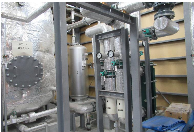
写真-7 現地視察「加護坊温泉さくらの湯」 木質チップボイラー施設の見学・研修
