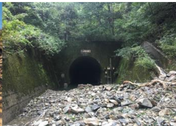
2019年10月三陸鉄道の台風による被害状況
