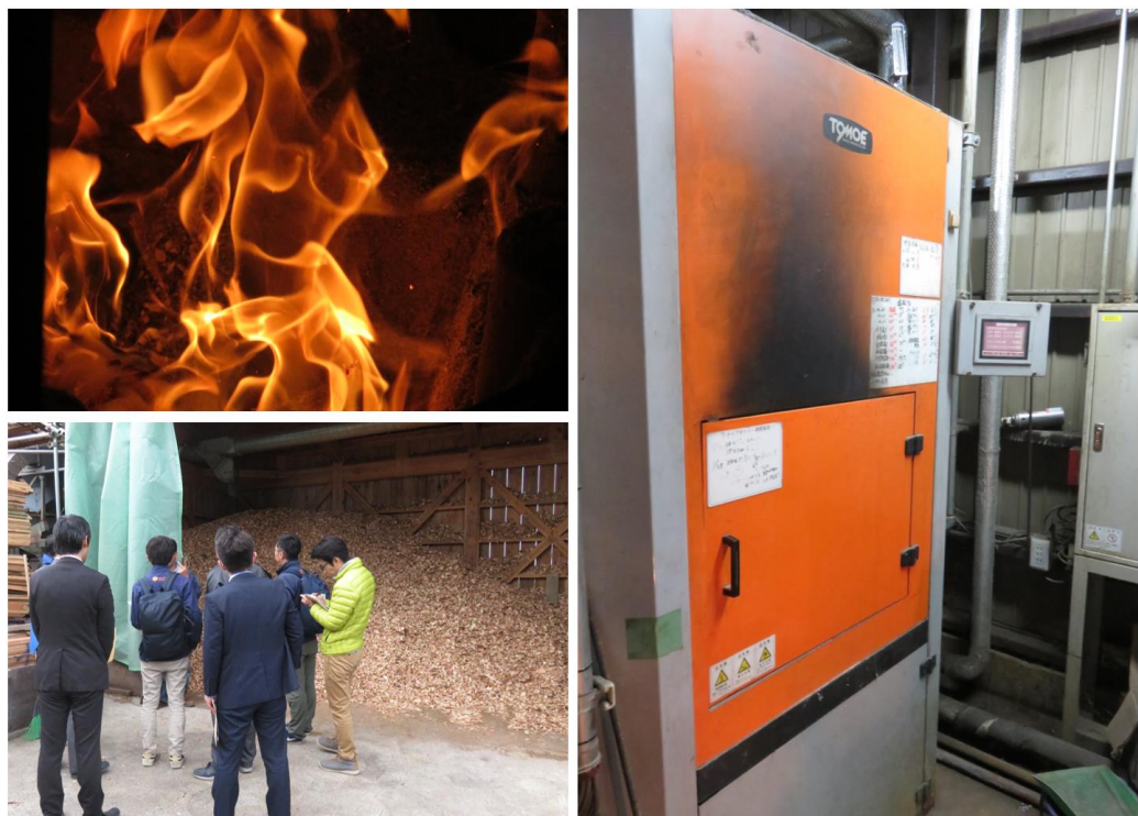
写真一 8 金山町森林組合のチップ保管庫と木質ボイラー
