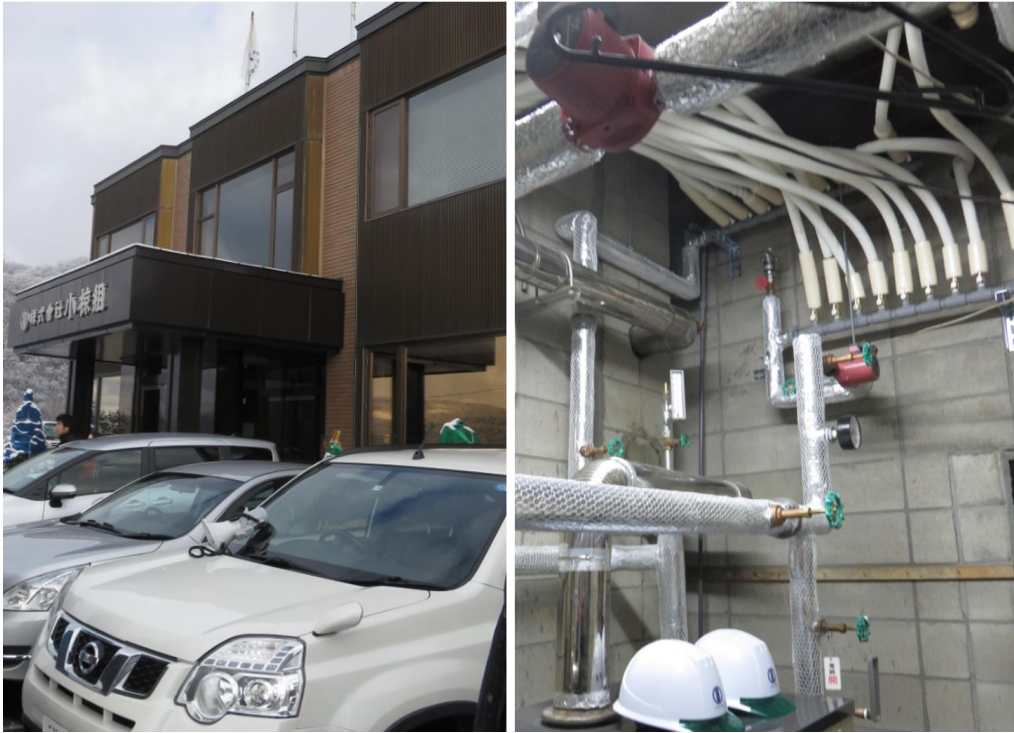
写真一 14 小椋組の外景と従来配管への接続状況
