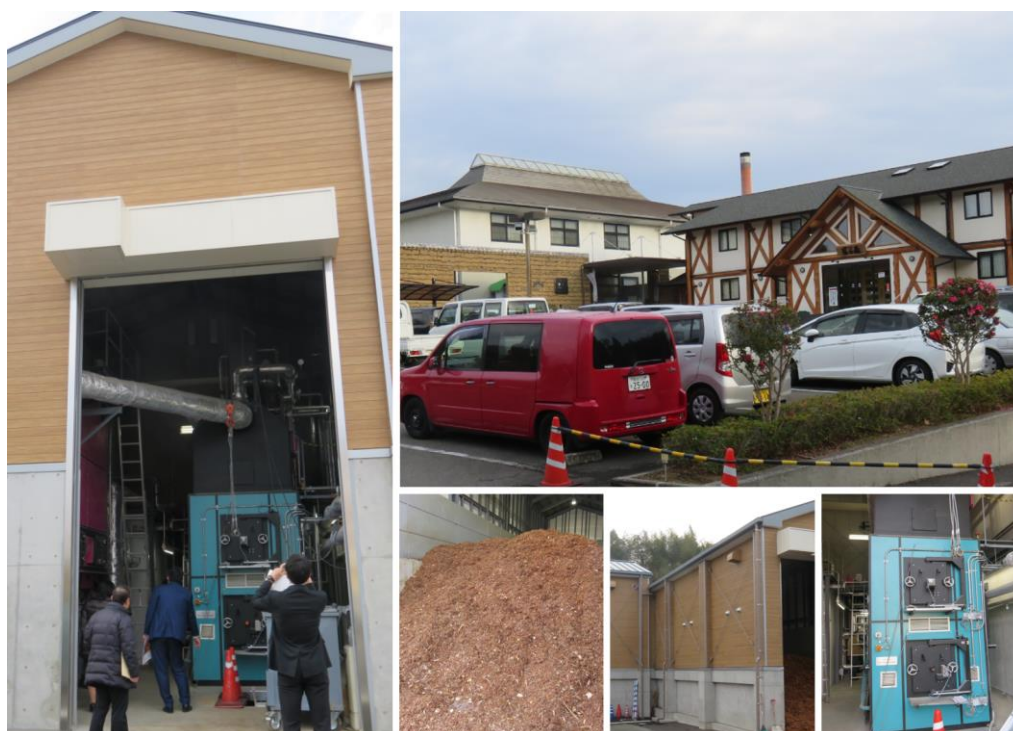
写真一 18 はるの湯の全景とボイラー施設・チップ保管庫
