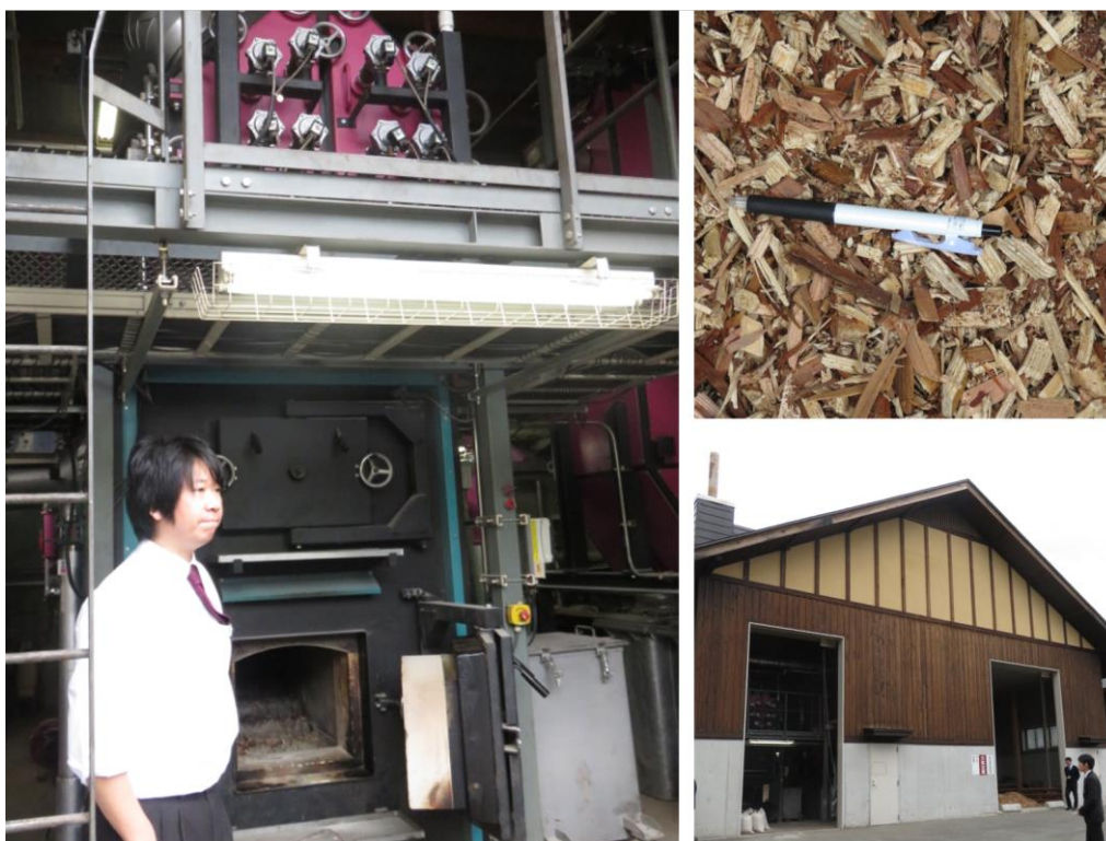
写真一 11 ホットハウスカム口のボイラー施設
