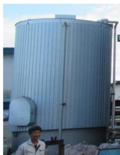
図－ 47 余剰蒸気利用の事例（蓄熱温水タンク）
