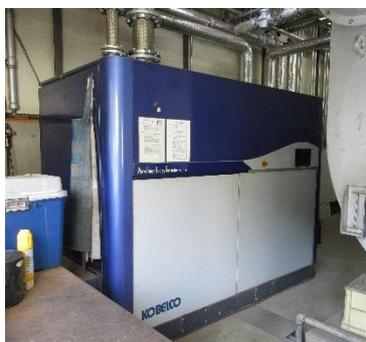
図－ 45 余剰蒸気利用の事例（スクリー式小型蒸気発電機）
