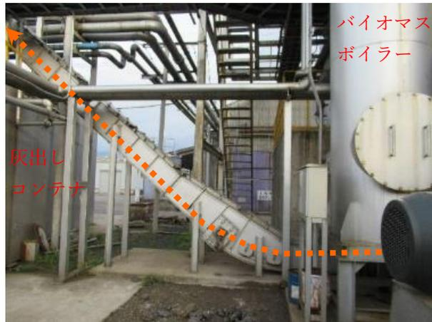
図- 54 灰出しの自動化の例
