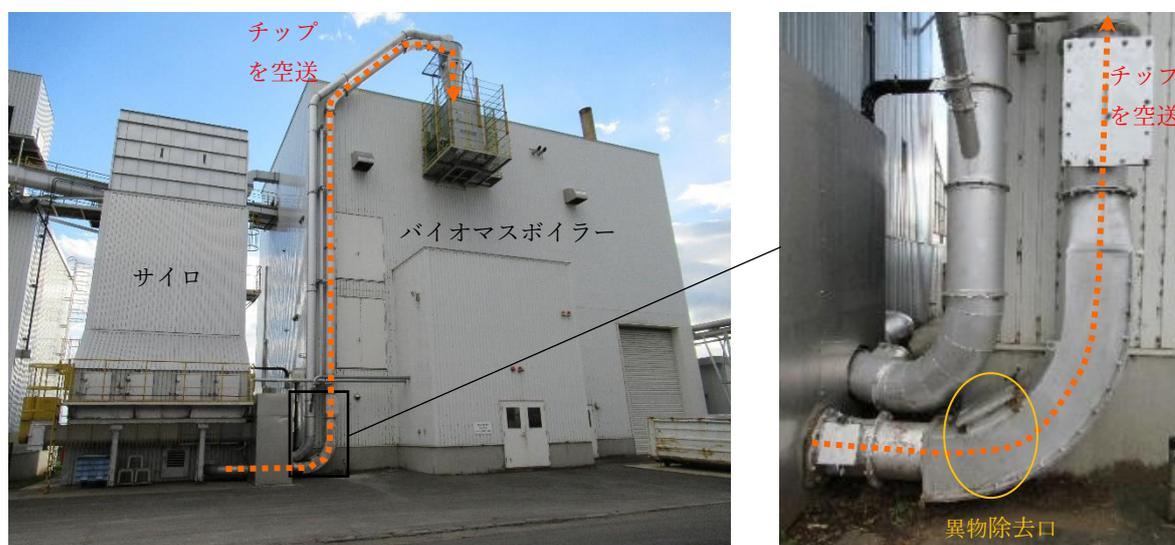
図－ 51 燃料の空気搬送（例）
