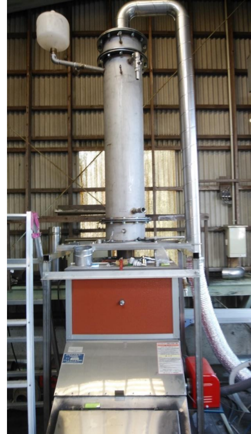
水冷熱交換器の容量 58kW (50,000kcal/時) 取付位置をボイラー直上へ変更
